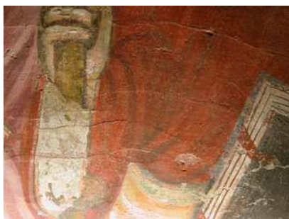
Foto 16 - Particolare (dettaglio macro della foto precedente) a luce radente. La foto documenta l'andamento irregolare della stesura della malta.
