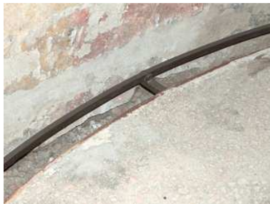
Foto 19 – Particolare del pavimento e della trincea lungo il lato interno dell'abside a completamento dei lavori: è visibile il livello originario dell'affresco.
