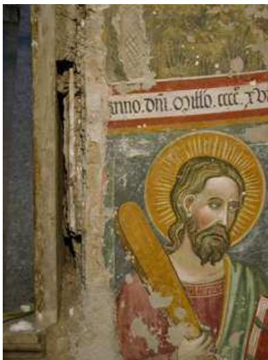
Foto 18 - Particolare durante la rimozione della stuccatura in cemento che chiudeva l'intercapedine tra l'abside e le lastre settecentesche in marmi policromi. Al di sotto di questa vi è una integrazione a malta e stucco in gesso, sul fronte dell'abside si intravede una cornice in stucco.
