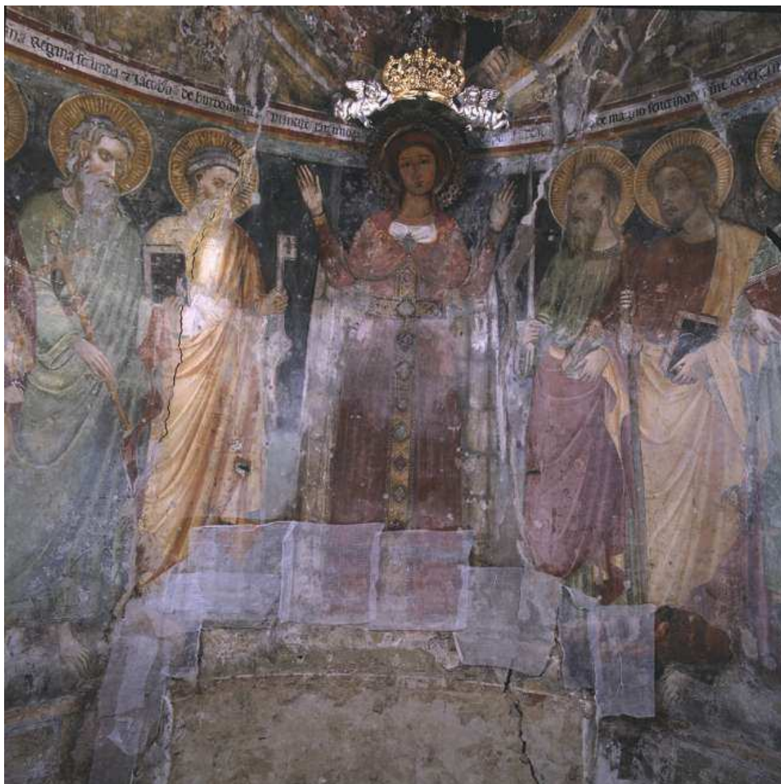
Foto 7 – Madonna, prima del restauro. La foto documenta gli sbiancamenti dovuti alle efflorescenze saline provocate dalla risalita di umidità dalla muratura.
