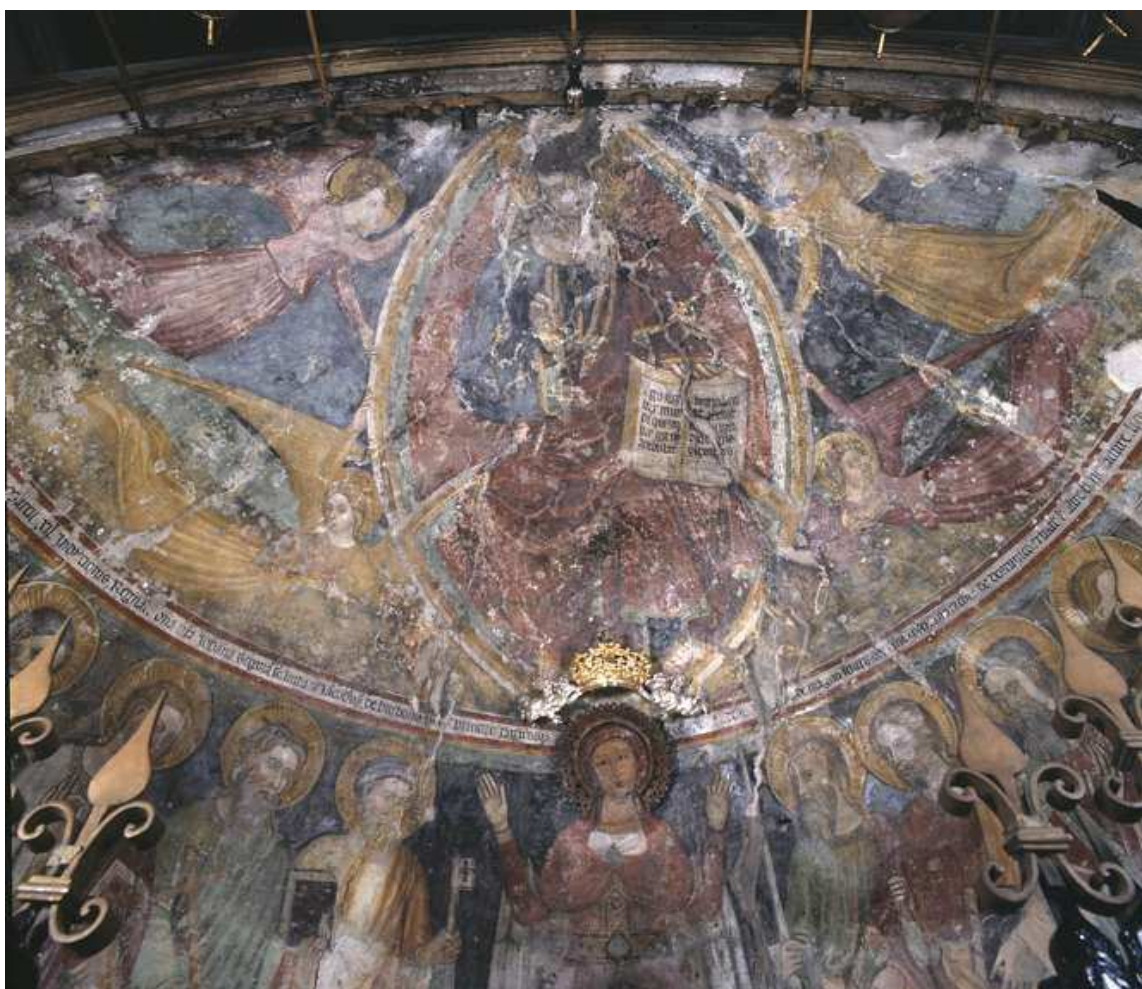
Foto 4 – Il catino absidale, particolare prima del restauro: al suo interno possiamo leggere chiaramente il quadro fessurativo.
